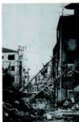
地震被害で押し倒された鉄柱 (関西電力兵庫営業所・点検への軌跡より)
