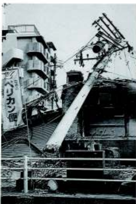
電柱が折れ倒壊が露出…豊田区 (関西電力兵庫営業所・点検への到着より)
